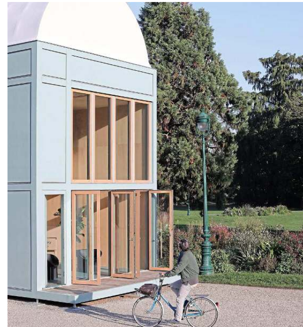
Cette maison sans fondation, à monter en cinq jours, résiste à des vents de 160 km/h et peut s'adapter aux déclivités du terrain.
