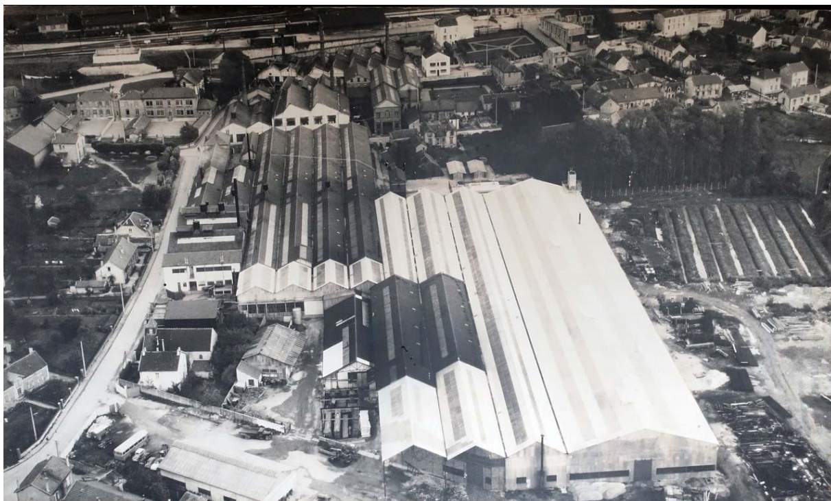
Créée au milieu du XIXe siècle, la friche industrielle Degond a été successivement occupée par une usine de précision en horlogerie, puis, jusqu'en 2003, par une entreprise spécialisée dans la fabrication de tubes en cuivre sans soudure (©Mairie de Longueville)
