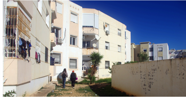
Résidence Walid 4, Atelier Suds
