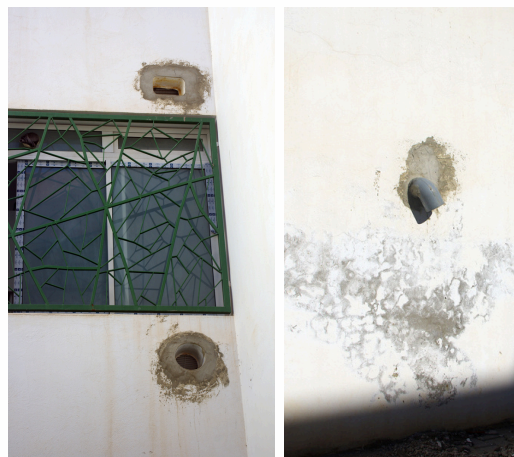
Aérations et bouche d'évacuation des eaux ajoutées par les habitants dans les résidences Saule et Sophora / Diamant et Rubis, Atelier Suds
