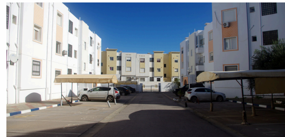
Résidence Walid 4, Atelier Suds
