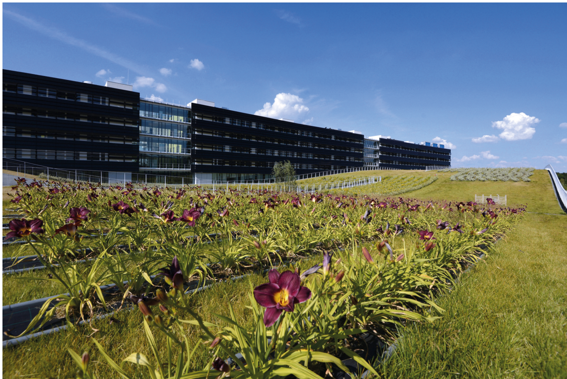
Cité Descartes. Bâtiment Bienvenüe : architecte Jean-Philippe Pargade. Photos Éric Morency © Epamarne.
