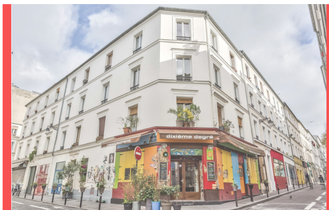
Quartier Sainte Marthe. Source: Edmond Coignet. https://www.edmondcoignet.com/realisations/rue-st-marthe
