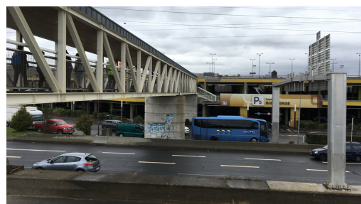
Passerelle piétonne entre le T7 et Belle-Épine, Louis Pelletier© 16 octobre 2019
