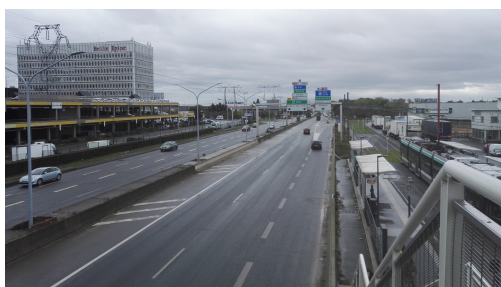
Voies rapides entre Belle-Épine (à gauche) et la future Cité de la Gastronomie (à droite, au-delà du tramway). Fiorella NOVAKOVSKI© 16 octobre 2019
